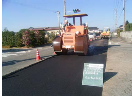
瀝青安定処理工施工状況
