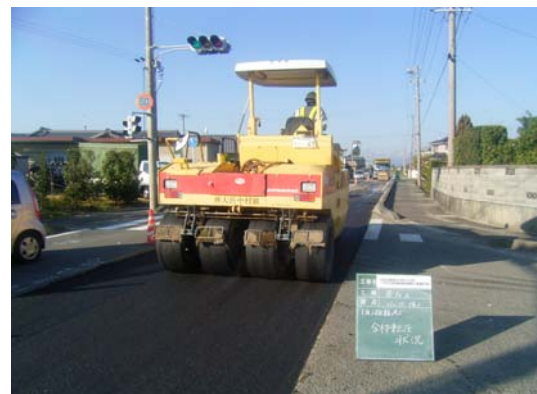
基層工施工状況
