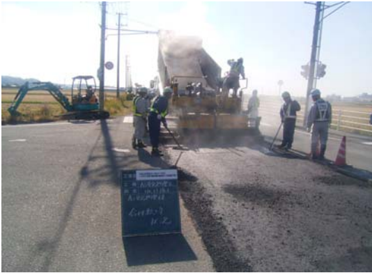
瀝青安定処理工施工状況
