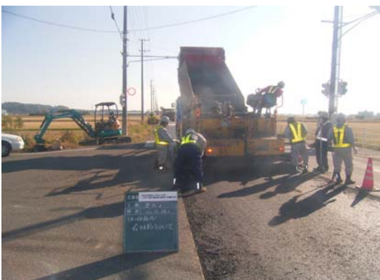
基層工施工状況
