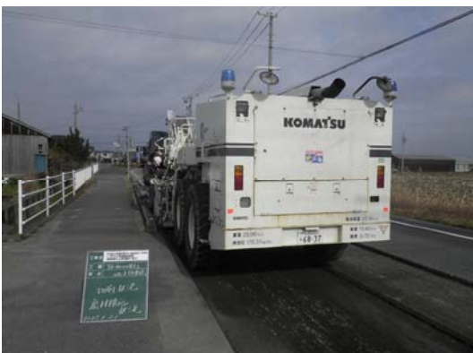
路面切削状況
