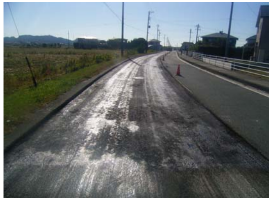
防塵処理乳剤散布完了
