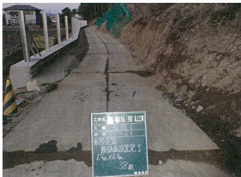
仮設道路設置
