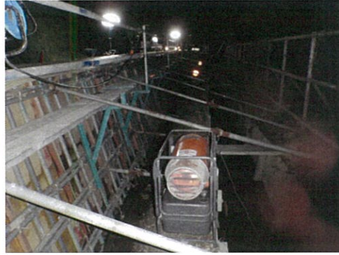
ジェットヒーター使用状況
