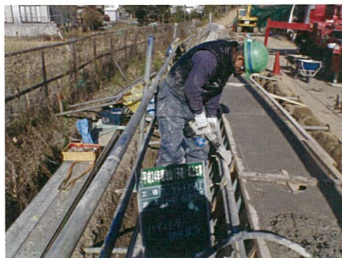
壁打ちバイブレーター使用状況
