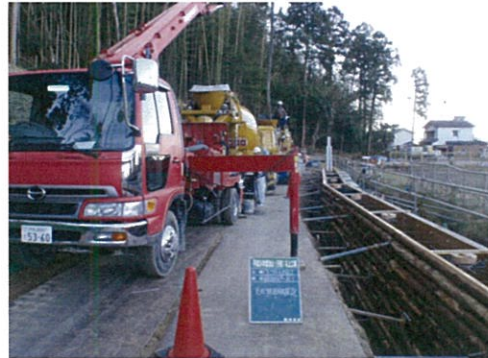
コンクリート打設状況
