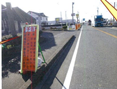
工事施工箇所
