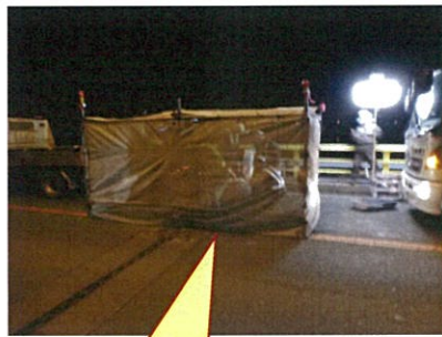
単管パイプを組み ネットで覆った
