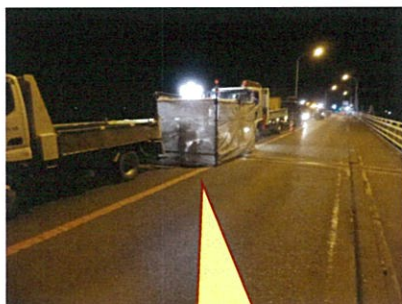
単管パイプを組み ネットで覆った
