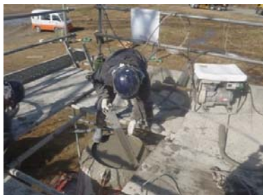
側面部の気泡抜き状況
