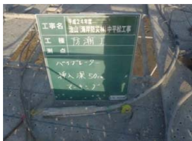
側面部の気泡抜き状況
