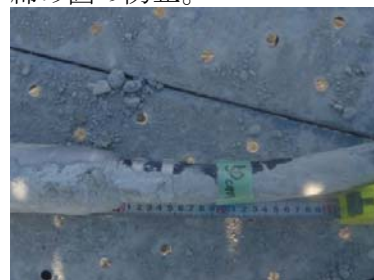
打設挿入深さのマーキング
