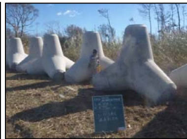
膜養生散布状況
