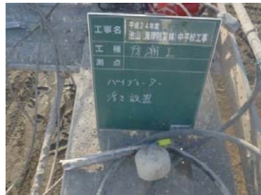
浮きの設置によりコンクリート投入時と共に浮力を利用し浮き上がり同じ箇所での締め固の防止。
