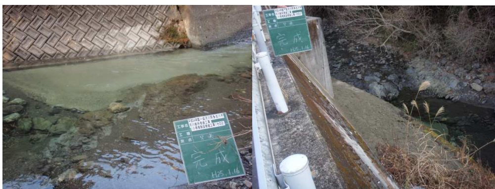
左は水中コンクリート打設完了 右はブロック裏込め材補充の様子
