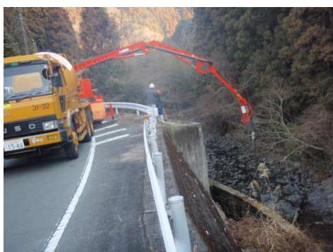
水中コンクリート打設の様子
