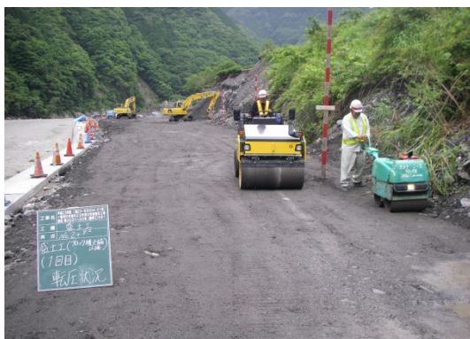
写真-2 転圧状況
