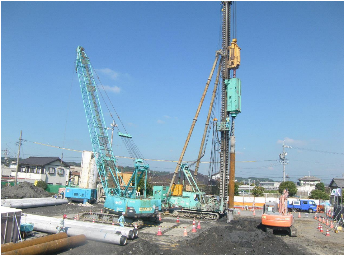
図-2 既製杭施工状況写真
