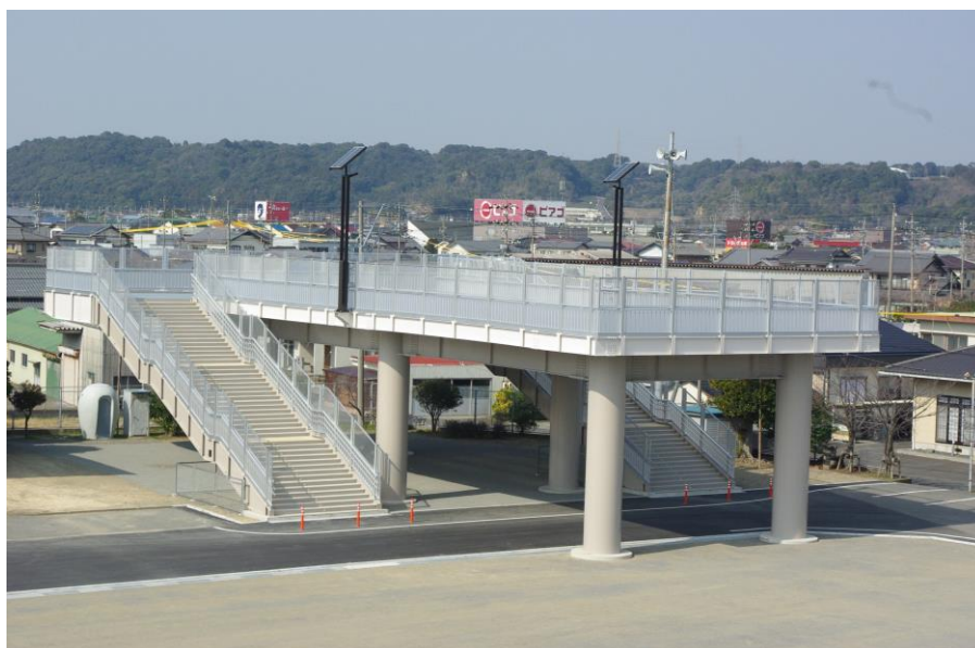
図-1 津波避難タワー完成写真
