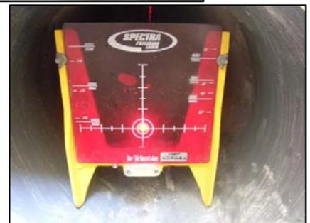
② マンホール内側に管天端高さより100mm上げの印をして、管口を固定する前に、再度高さの確認を行った。マンホール設置箇所からの排水管布設は、レーザー測定器での布設ができない。従来通り、レベル、トランシットによる高さ、通りの管理を行うが、管下の砂基礎の高さを勾配通り敷均し、転圧したつもりでも管口部の高さを決め、上流部の高さ確認し、管を固定するのだが、少しの誤差で管口の高さが変わってしまっていたりすることがあった。この為、100mm上げの印をすることで、布設完了した管を再度高さ確認する事ができ、手戻りを防いだ。
