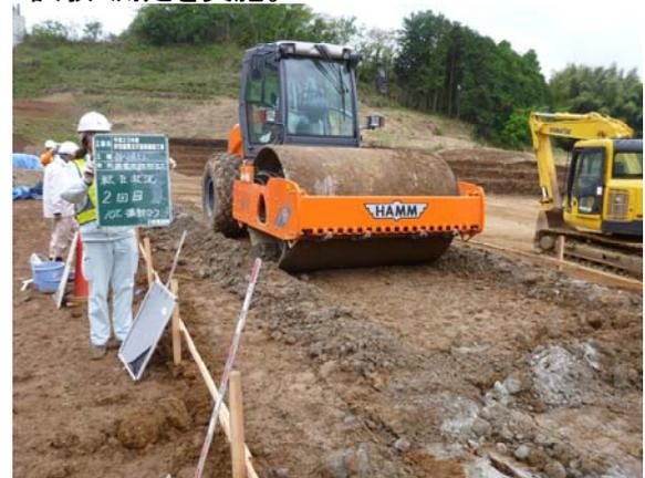
各転圧完了後、転圧面の高さを確認し、改良前の高さと比較することにより、土量の管理・締固めの目安として利用した。
