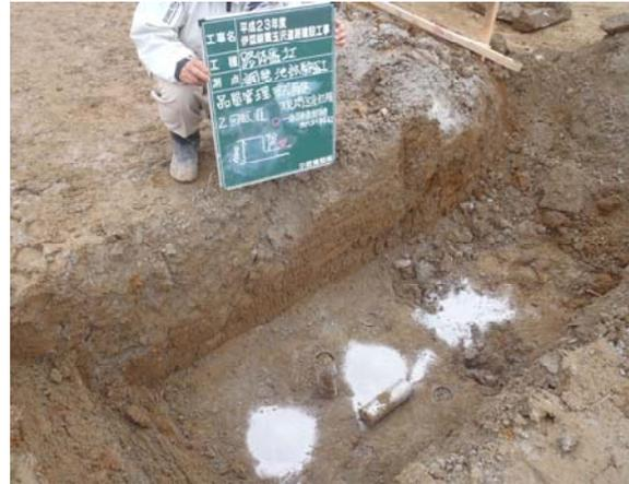
下部H=0.3mにおいても、一軸圧縮強度試験・現場密度試験・六価クロム溶出試験を実施し、合否判定を行った。
