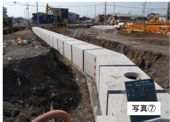
埋戻し時に巻出し厚を安定させるため、短い距離で厚さ表示し施工した。(写真⑧)
