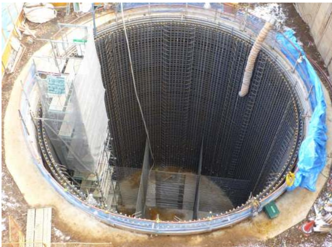
深礎工施工状況
