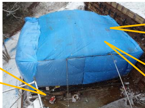
橋脚躯体(柱部)シート囲い養生
