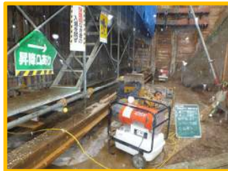
ジェットヒーターによる内部保温
