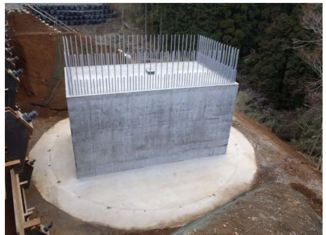
RC橋脚工全景
