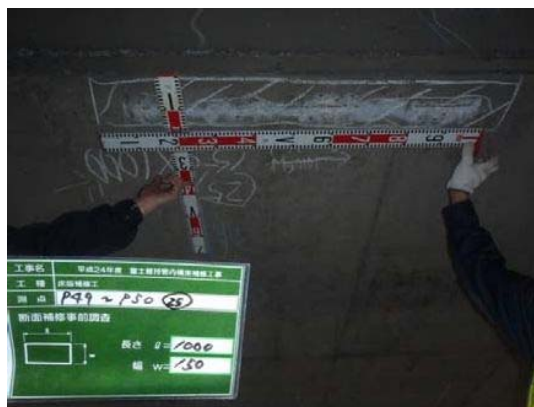
断面補修調査写真
