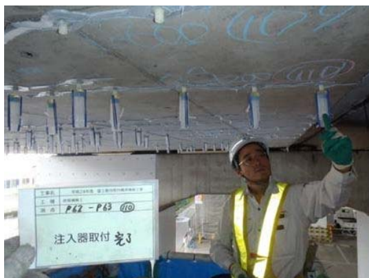
施工状況写真
