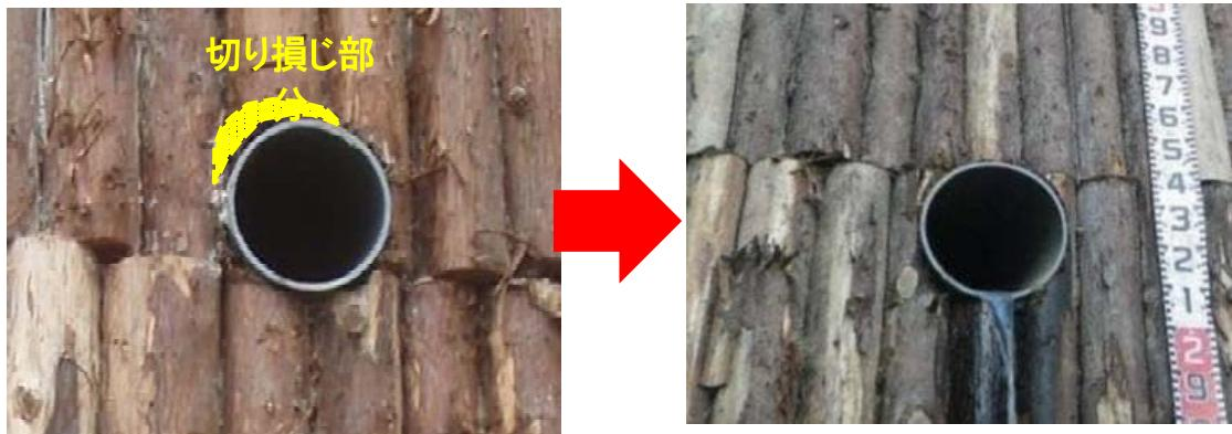
ウッドカービングチェーンソーを使用した結果、非常に小型で軽量であり、先端も鋭利である為、細かな加工や狭い場所での作業に適しており、その後の作業効率が向上し、出来栄えも良いものとなつた。
