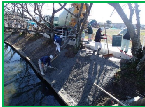
図6 張コンクリート打設の状況
