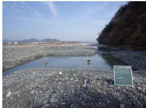
写真 6-6 沈砂池の濁水対策フィルター3列
