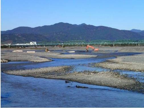
写真 6-2 瀬替え工：完了測定
