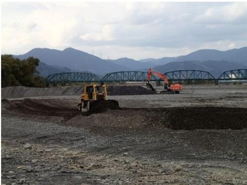
写真 6-4 仮締切工：施工完了
