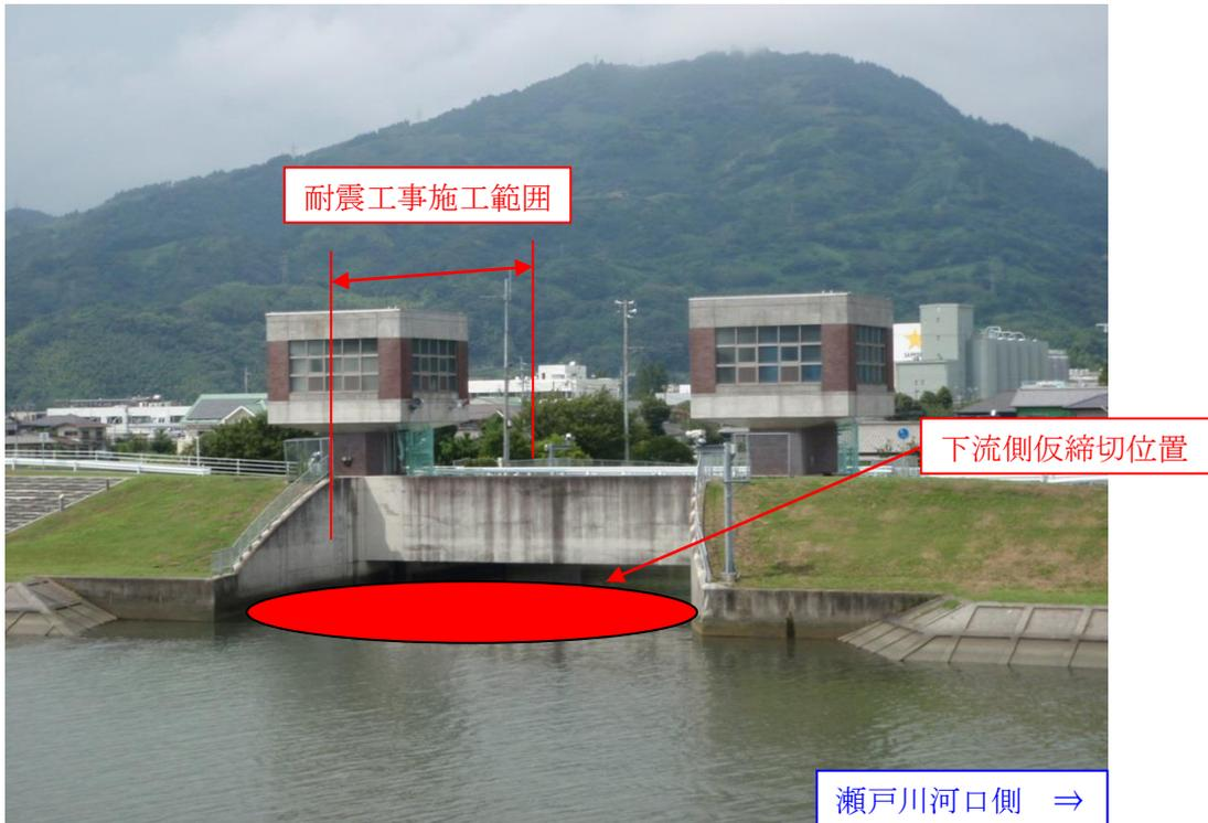
図-2 当初仮締切工詳細図
