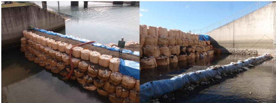
(大型土のう締切完成写真：仮設道路を兼用した構築の完成)
