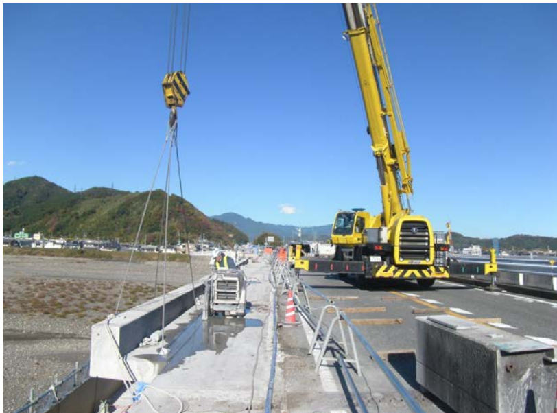
床版コンクリート切削 吊上げ地切りの状況
