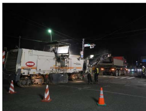
路面切削状況
