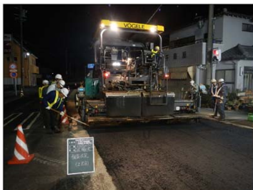
TV併用AF大粒径混合物敷均し状況
