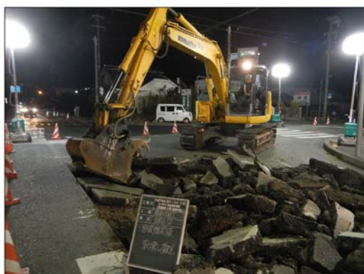
既設舗装版ロードタイロン破碎
