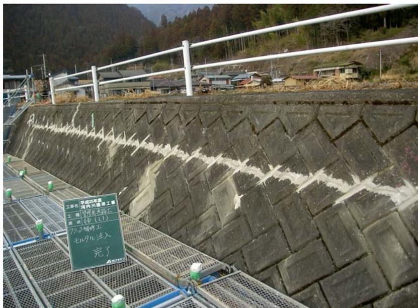
写真：ブロック積復旧完了
