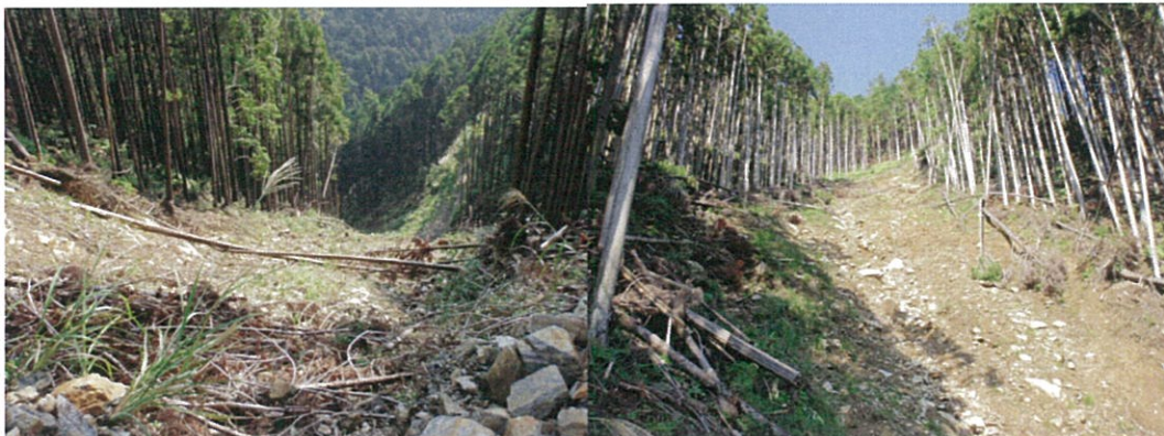
山腹工施工個所を上部・下部より望む
