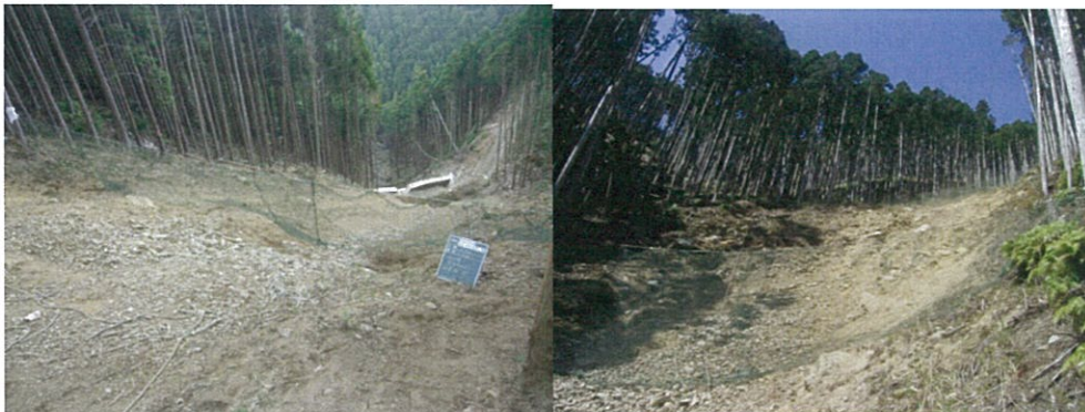
落石防止ネット施工後の様子
