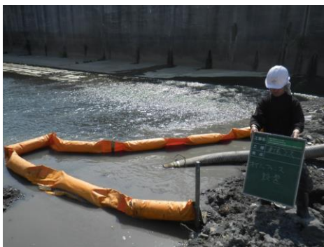
写真③ （オイルフェンス設置）
