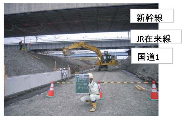
2.9t吊りクレーン仕様バックホウの使用状況 写-2
