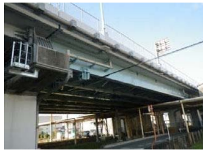
現場塗装工、剥落防止工
