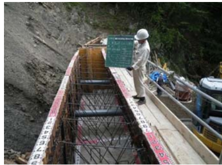
組立完了の出来形写真
