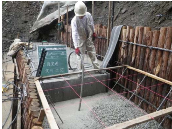
打設定規を用いての締固め状況
