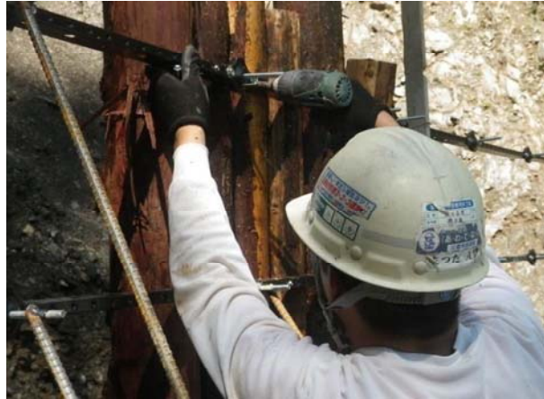
丸太材設置状況
