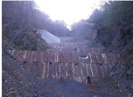
(34崩 コンクリート土留工 4基 完了)
