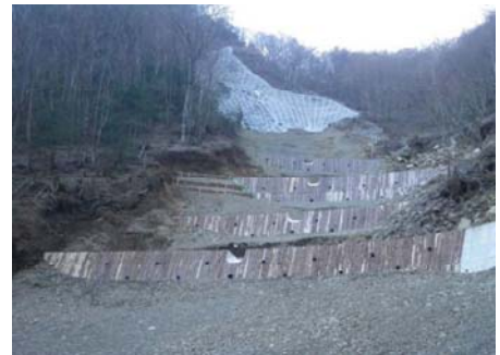
(35崩 コンクリート土留工 4基 完了)
