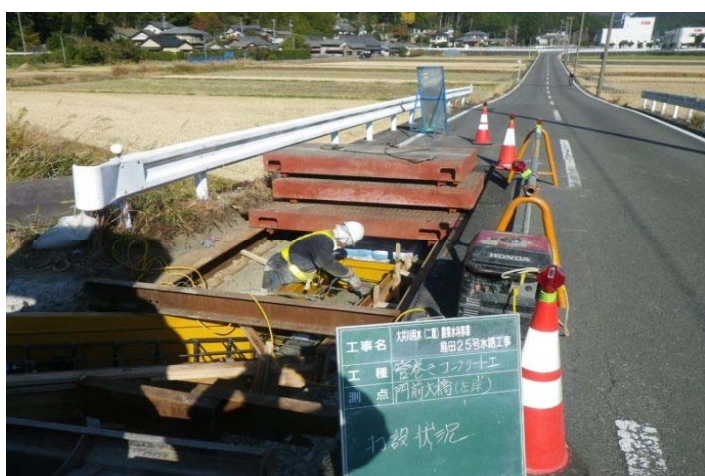
覆工板設置した作業①
