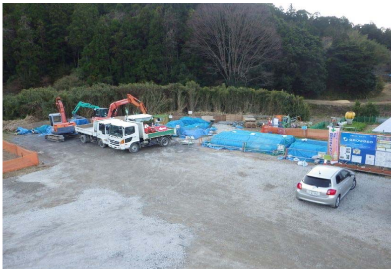
資材置き場ヤード設置
