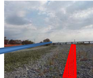
当工区仮排水路施工箇所
