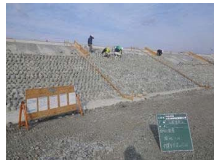
石張り施工状況 (上段部)
