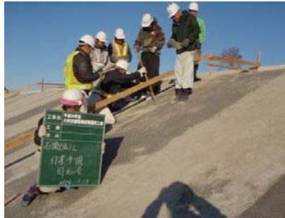
現地作業手順確認
