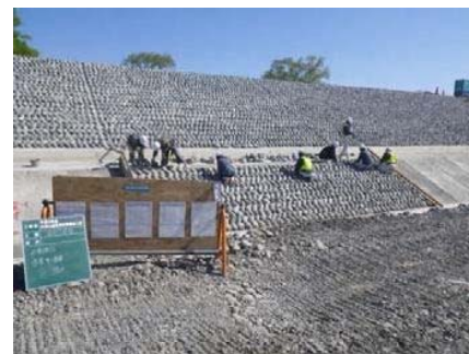
石張り施工状況 (下段部)
