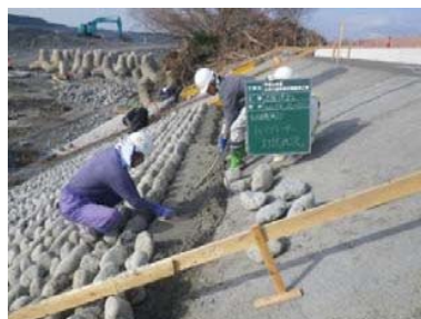
コンクリート打設状況
