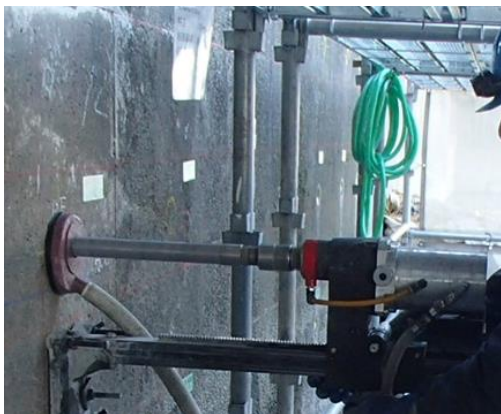
特殊コアドリルによる削孔状況
