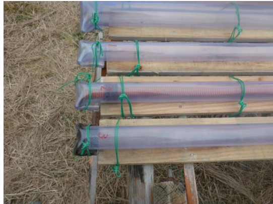
充填ホース挿入状況
