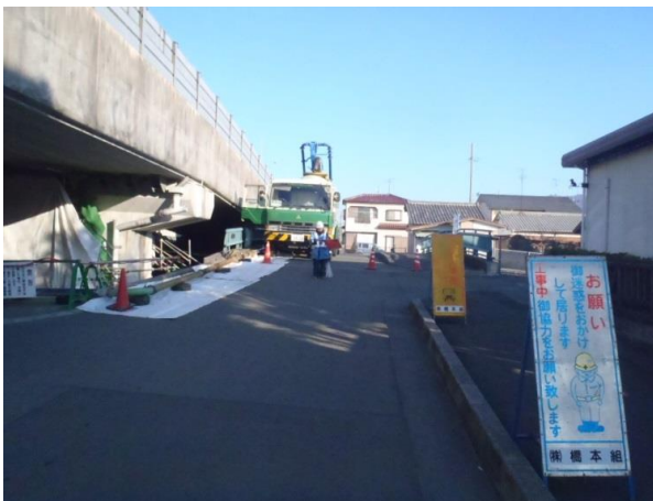
ポンプ設置状況
