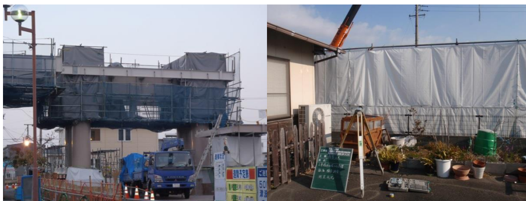
写真-5 養生設置状況
