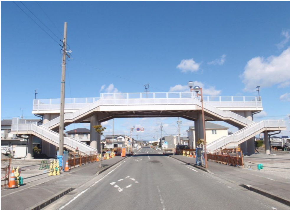
完成写真①
