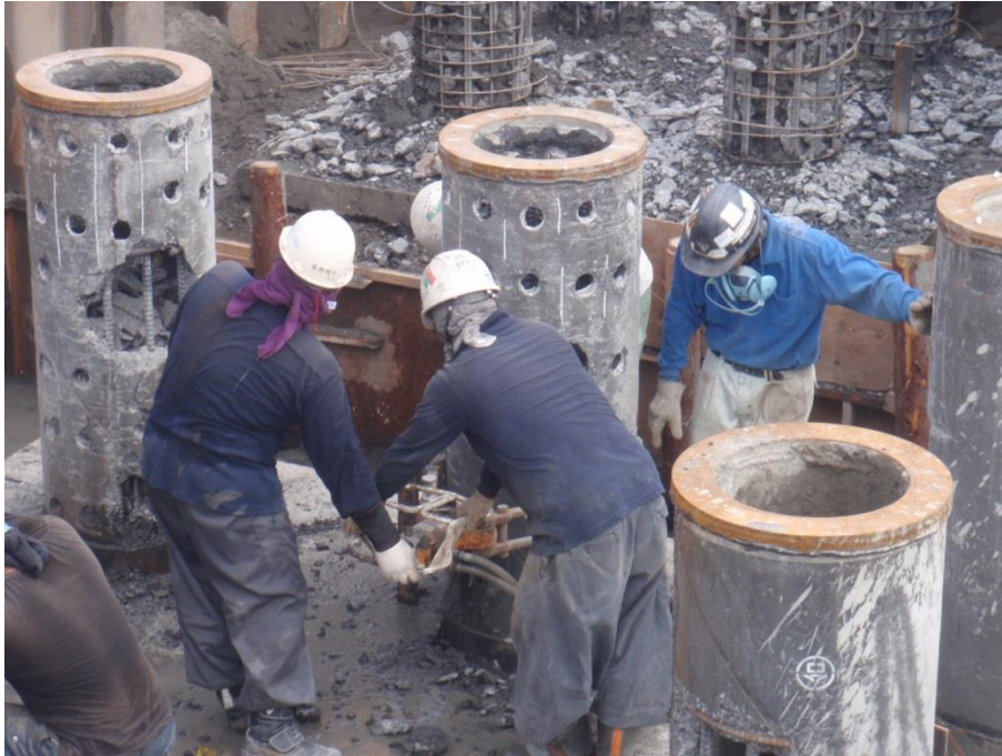
写真-3 杭頭処理施工完了状況
