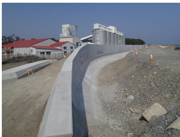
波返躯体施工完了(2月下旬)
