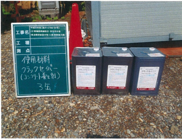
写真5 養生材（クラックセイバー）
