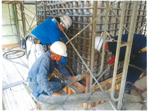
写真3 バイブレータによる締固め状況
