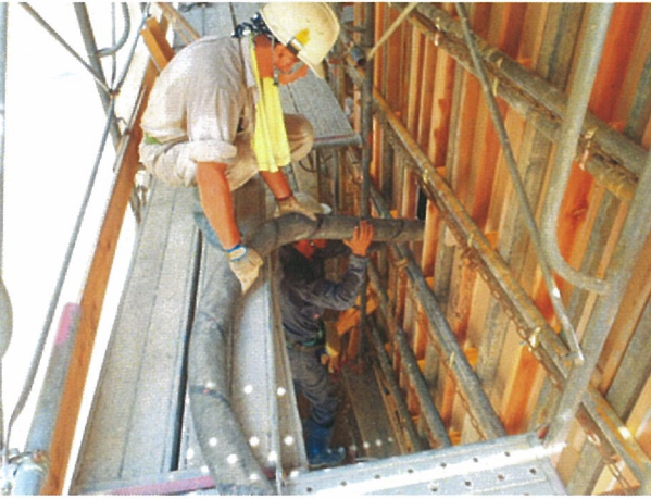
写真2 投入口より打設
