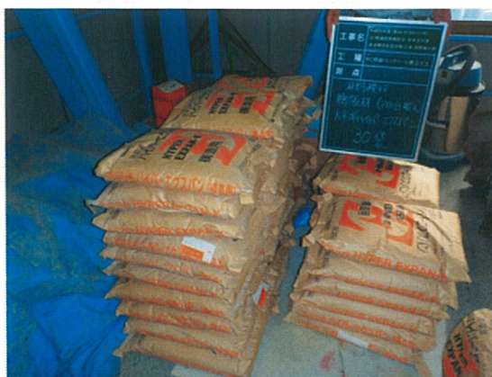
写真1 膨張材（太平洋ハイパーエクспан）搬入
