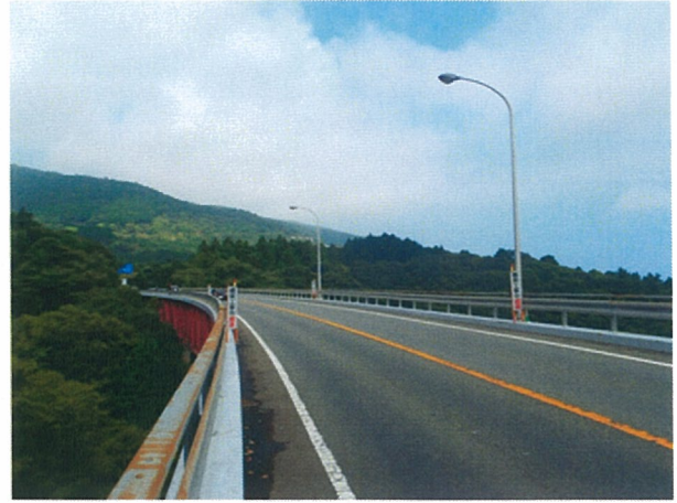
写真 11 減速看板設置
