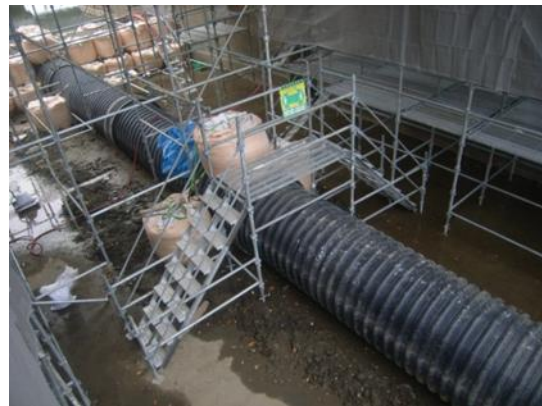
連絡通路設置
