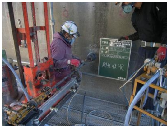
Phbドリル削孔状況
