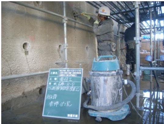
耐圧版面上での作業風景
