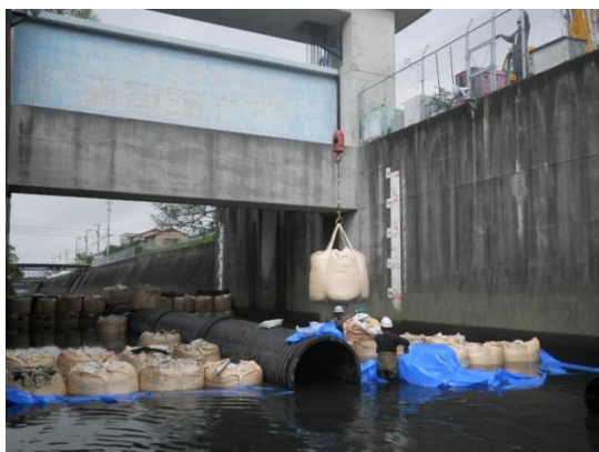
干潮時の仮締切設置と排水管設置状況
