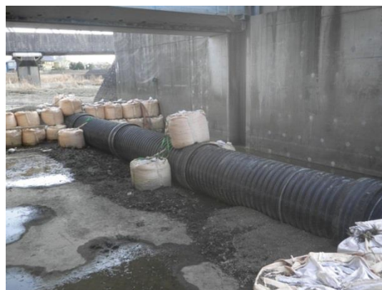
大型土のうによる管の固定
