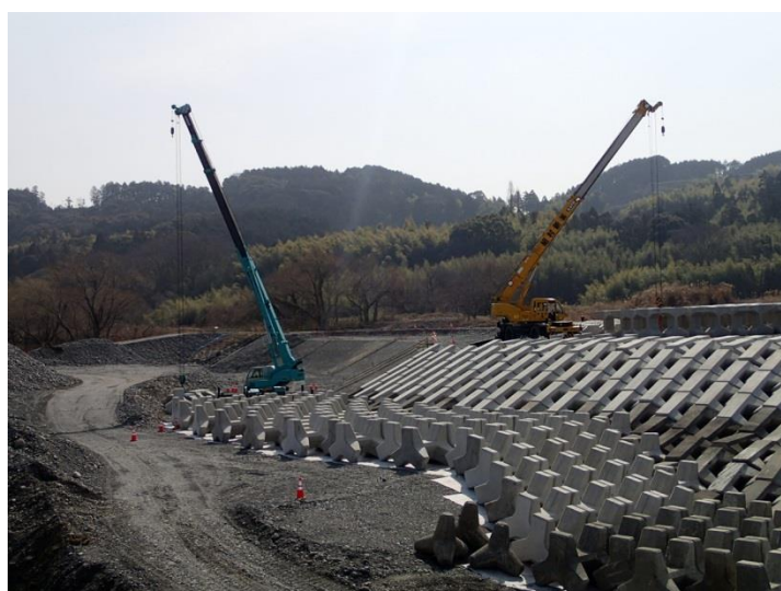
取付工・根固め工施工状況
