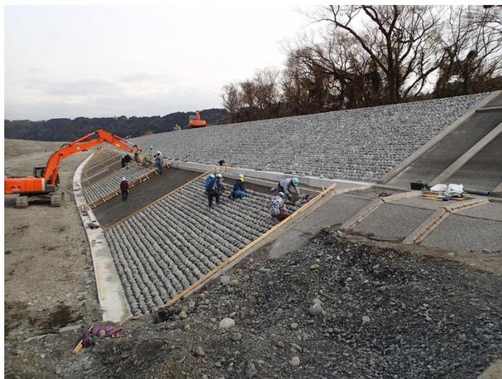
玉石張り下段部②施工状況
