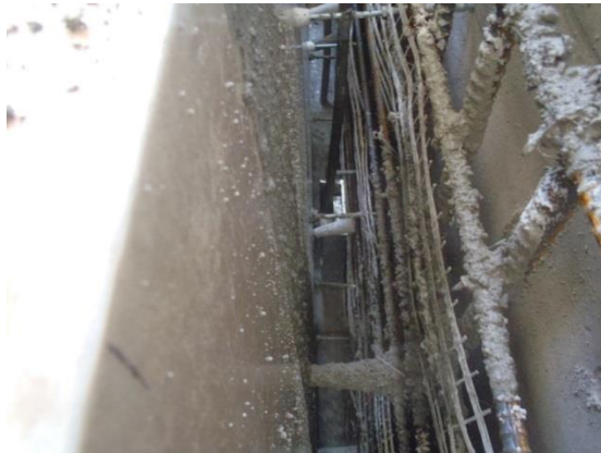
写真：ハイパーネット 60（コンクリート打設状況）
