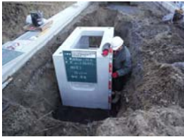
ハンドホール設置
