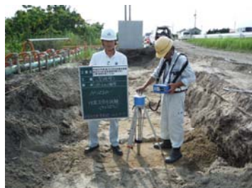
簡易支持力試験(キャスボル)
