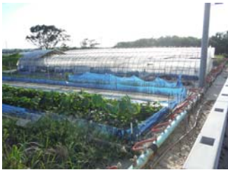
ウェルポイント設置
