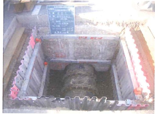
施工状況写真-1
