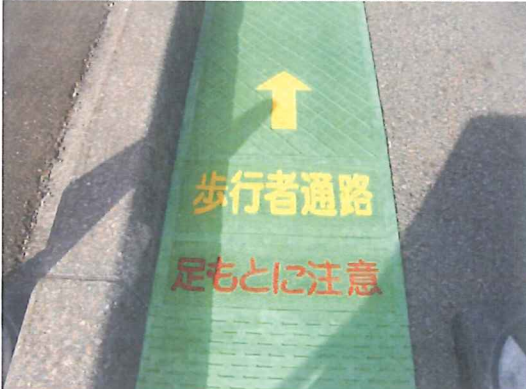
43号空気弁工 歩行者通路確保状況
