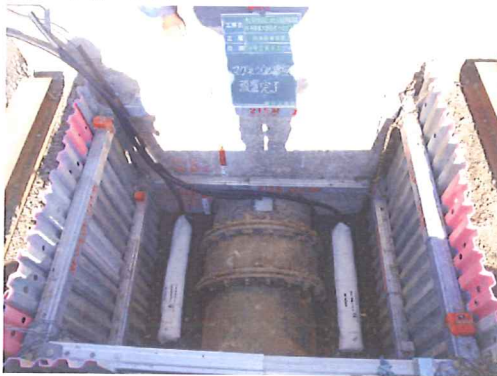
施工状況写真-3
