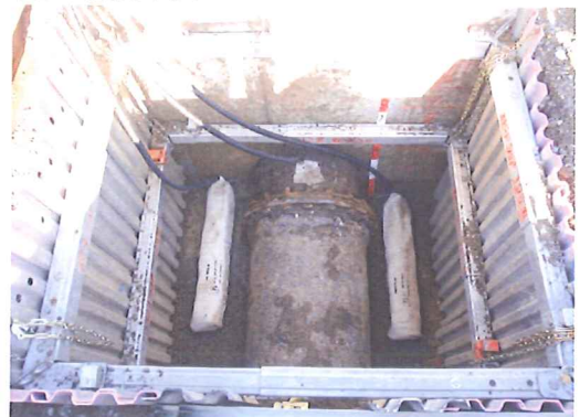
施工状況写真-4
