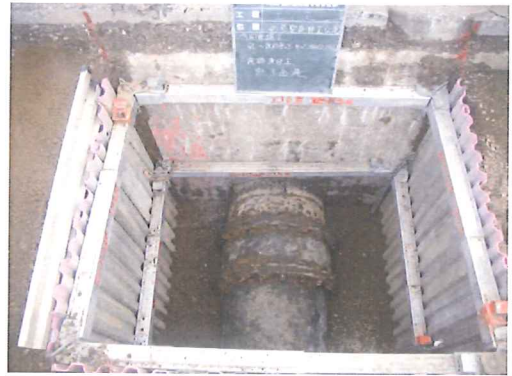
施工状況写真-2
