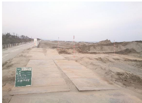
待避所設置状況
