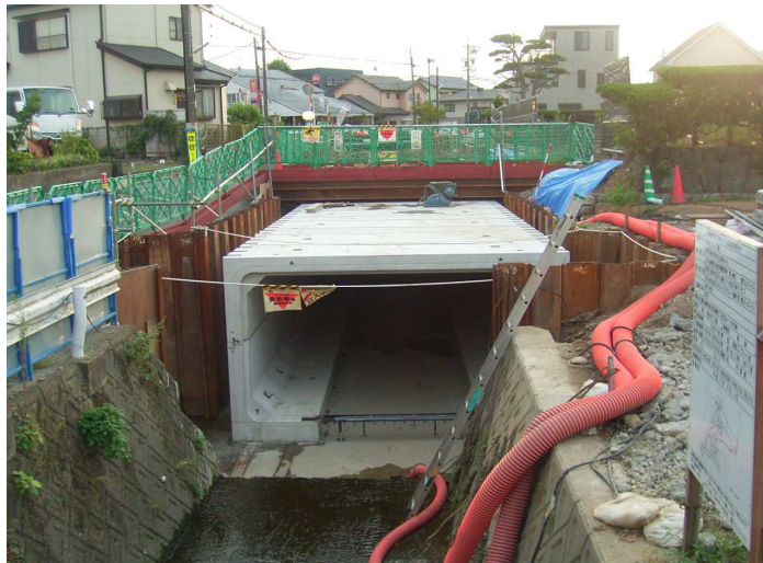
上流側より工事箇所捨川を撮影
