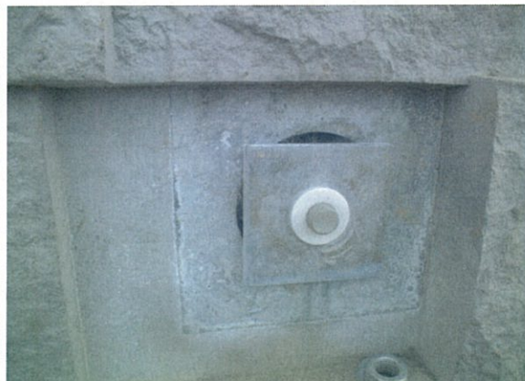
(定着プレート取り付け)
