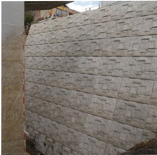
PAN WALL 工法設置完了状況
