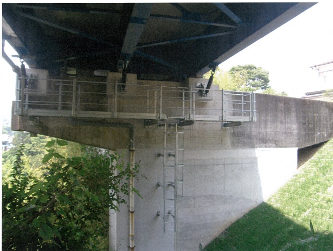
コンクリート充填完了写真
