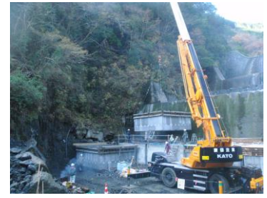
現地組立後設置
