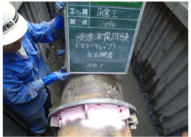
浸透深傷試験実施
