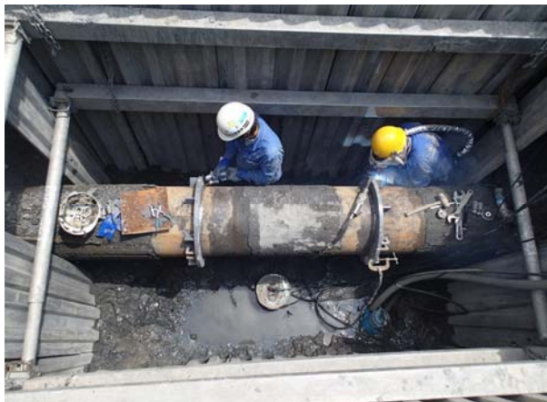
離脱防止リングの取付け状況
