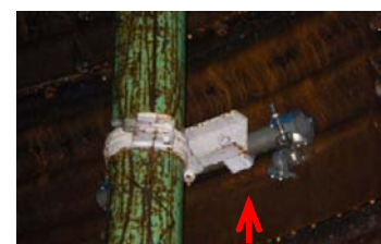
配管の補強リングへの 固定状況
