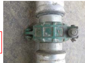
ワイヤー設置状況
