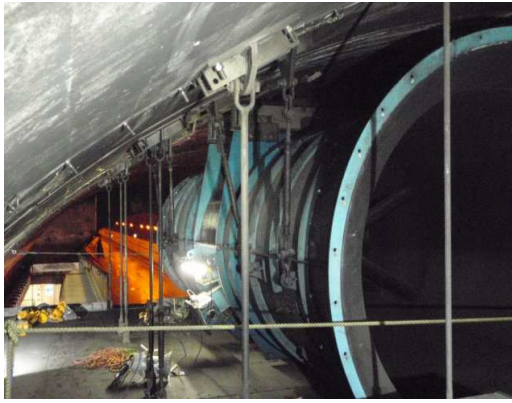
送風機撤去前に事前準備で吊り金具からチェンブロックへ盛替え作業
