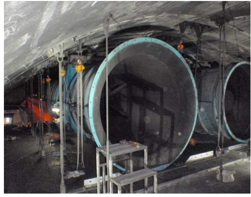
送風機撤去前に事前準備で吊り金具からチェンブロックへ盛替え作業
