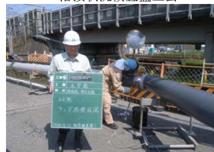
溶接状況検査監立会
