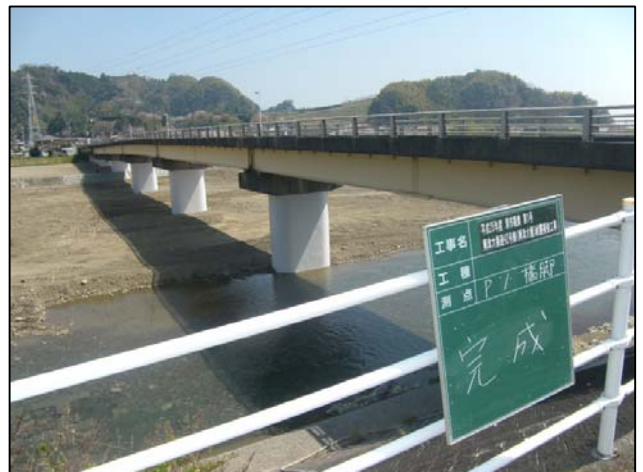
完成(P1橋脚からP7橋脚)
