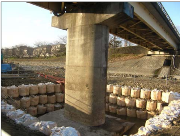
大型土のう設置による土留め
