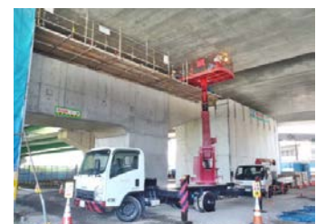
写真-12 設置状況
