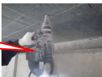
写真-4 試験削孔
