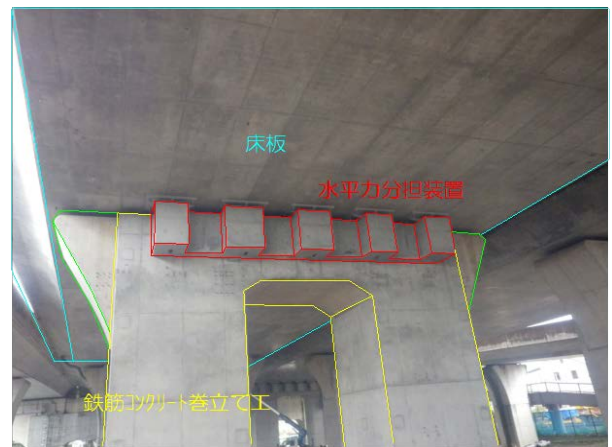
写真-1 施工完了写真
