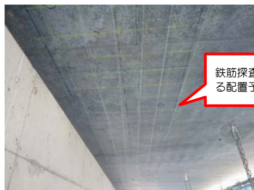
写真-3 鉄筋探査完了
