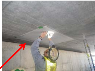
写真-8 寸法取り状況
