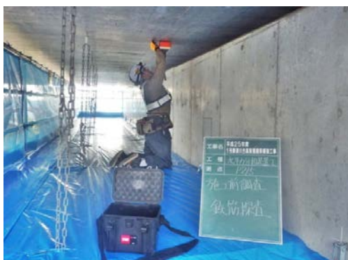
写真-2 鉄筋探査状況
