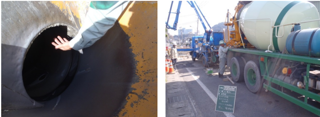
写真：生コン車へ投入・攪拌状況
