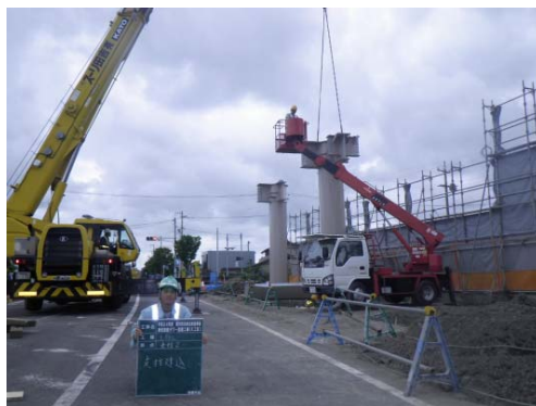
【一体化した状態で建柱】
