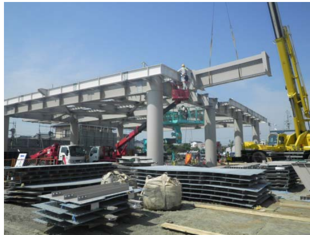
【高所作業車による作業床の確保】
