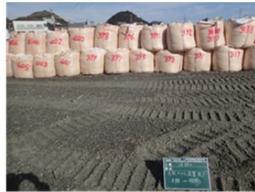
下流の土のう締切
