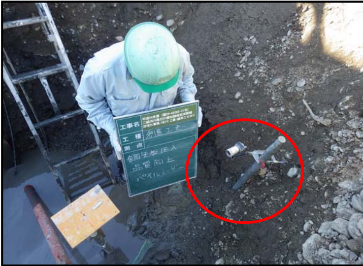
(写真 4-2 パイルレーザー)
