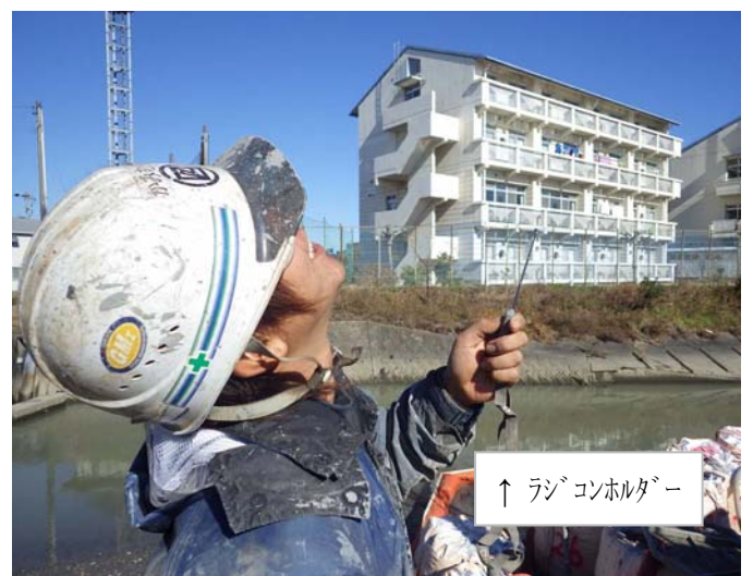
(写真 2-4) 遠隔操作で安全に玉はずし
