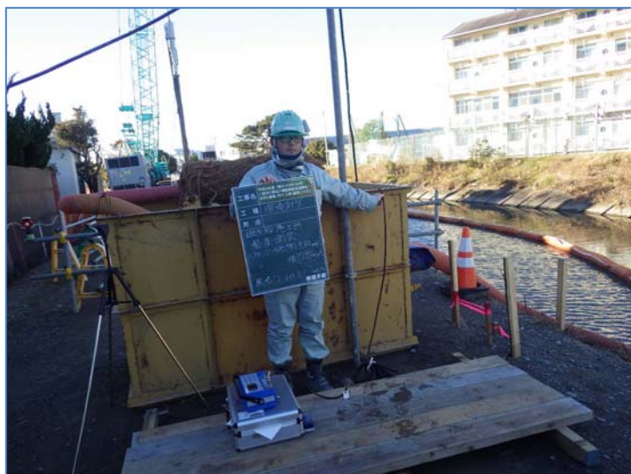
(写真 3-3 濁度測定状況)
